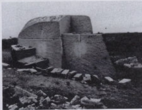
Photo 4 : Entre Coat-Mocun et Saint-Vinéc. Débitage systématique d'une boule isolée sur le sol. La roche, très saine, est fendue selon trois directions perpendiculaires, avec un minimum de déchets (entreposés au premier plan). Bientôt, la boule aura entièrement disparu sans guère laisser de traces [22/08/1956].
