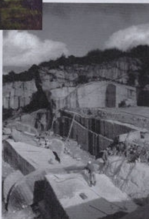
Photo 7 : Vue partielle de la grande carrière de Roz Perez, exploitée par la SORODEC. Extraction par la méthode des trous de perforation. [17/10/2000].
